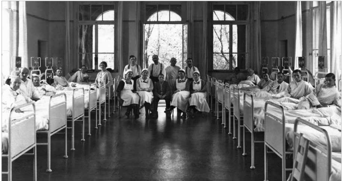
Krankensaal, Städtische Krankenanstalten Mannheim, 1928
